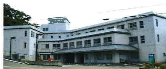
敦賀温泉病院 TSURUGA ONSEN HOSPITAL
